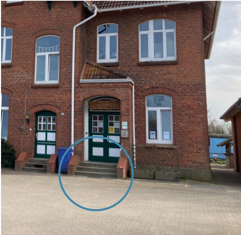
Foto: Zugang Kita (Treppenstufen)
